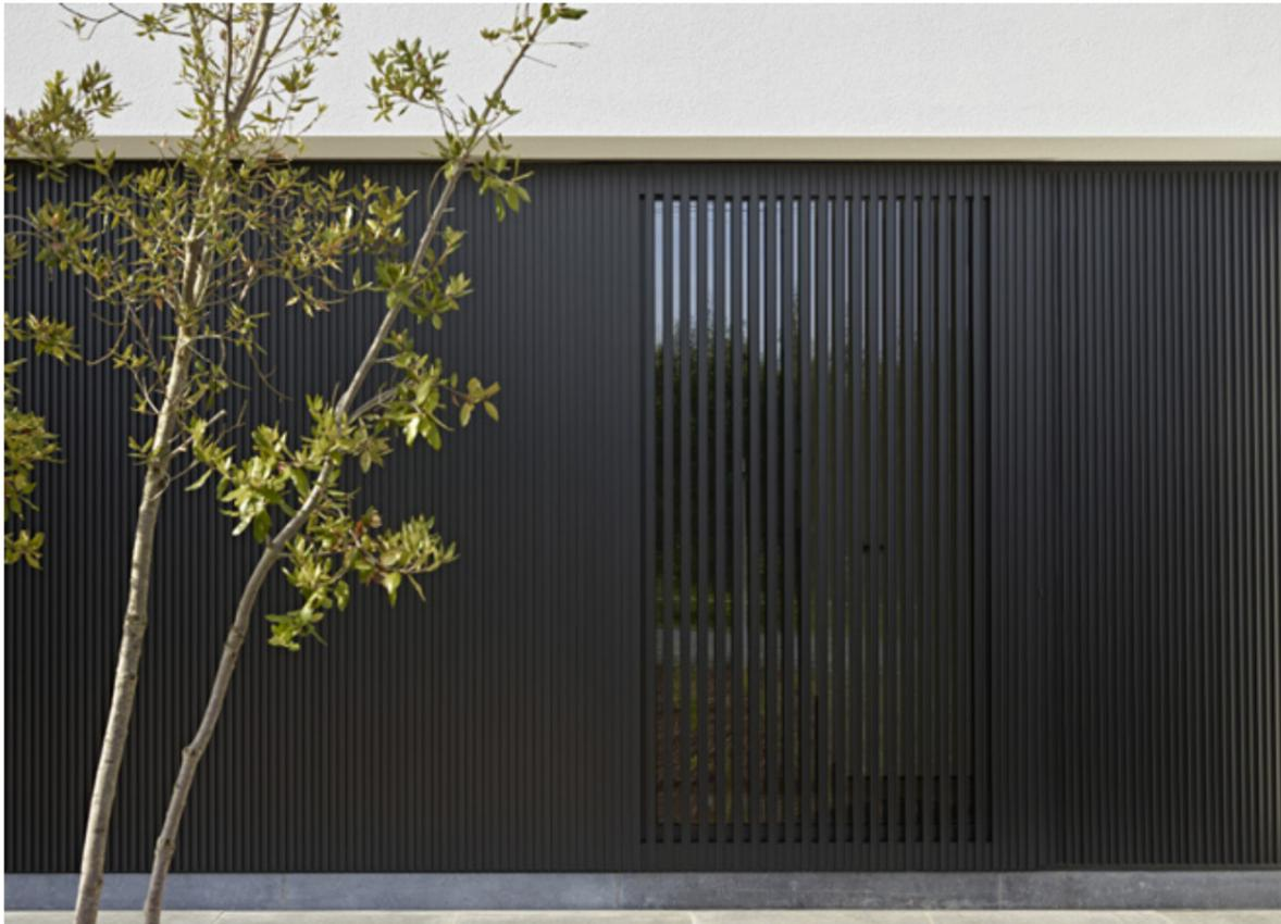
Mit den halboffenen Linarte-Profilen bieten wir eine ästhetische und funktionale Lösung für partielle Fensterverdunklung. Die vertikale Linienführung von Linarte kann auch bei einer Öffnung oder einem Fenster in der Fassade fortgeführt werden. Auf diese Weise verschwindet auch das Fenster in der Fassade, wird der Lichteinfall gefiltert und entsteht eine intime Atmosphäre. Die Rückseite wird mit einem Aluminium-Abdeckprofil in der gleichen Farbe ausgeführt.
