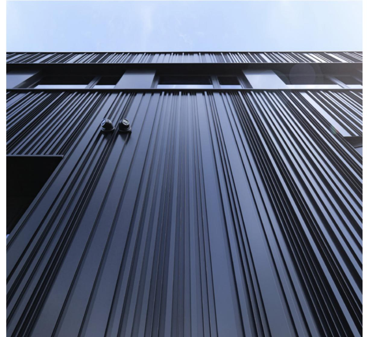
Renovierung eines Bürogebäudes mit einer dynamischen Fassade, bei der tiefschwarze Linarte-Profile in einer verspielten Kombination den gewünschten ersten Eindruck hinterlassen.
