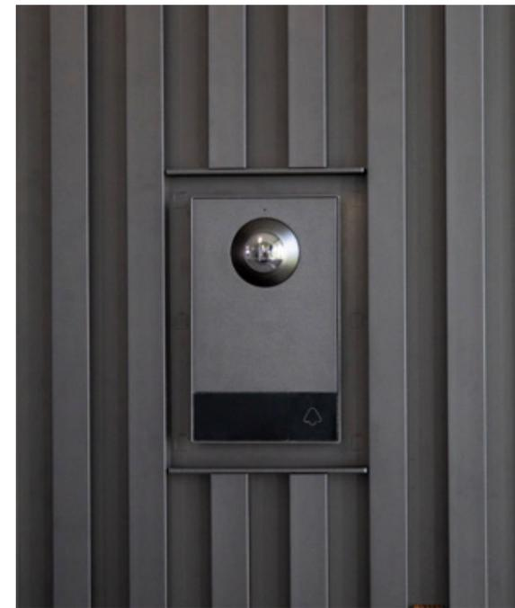
Die Video-Türsprechanlage wird nahtlos in die Fassadenverkleidung integriert. Hierzu dienen speziell entwickelte Module mit Blindplatte in der gleichen Verarbeitung wie die Fassade.
